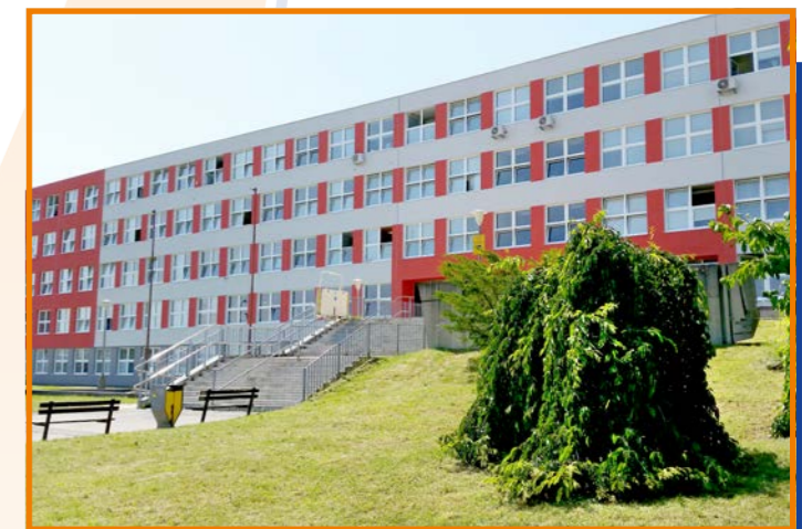
Pavilon A po rekonstrukci
