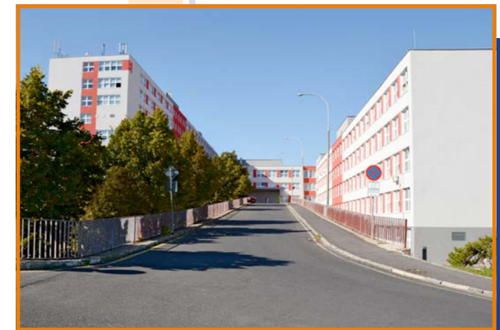
Přijem mostecké nemocnice po rekonstrukci
