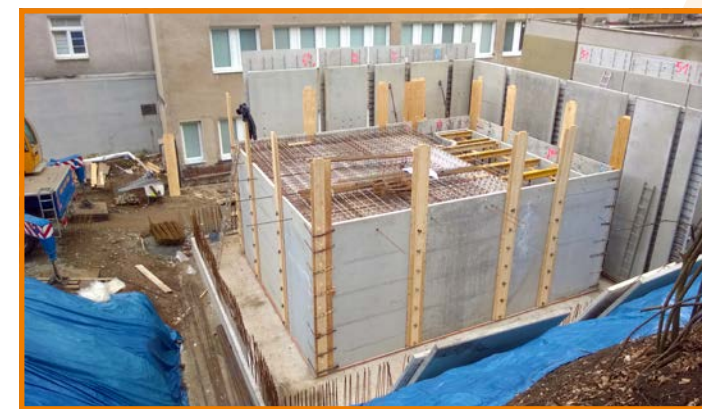
Výstavba stínicí kobky pro lineární urychlovač
