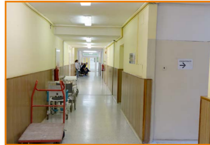
Chodba před rekonstrukcí
