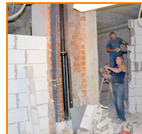
Rekonstrukce dětského pavilonu přináší řadu bourání a budování nových přiček
