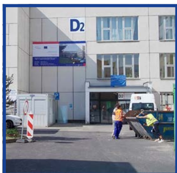
Rekonstrukce dětského pavilonu MNUL, o. z. čtěte na str. 7
