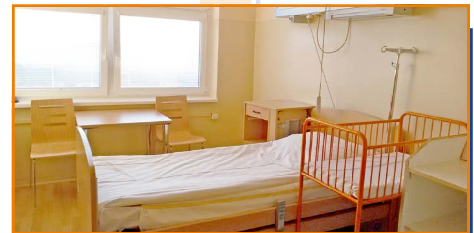
Nadstandard před rekonstrukcí
